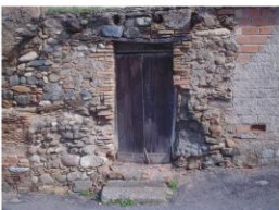
Visa del muro portante misto.
