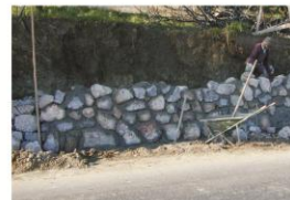
MURO DI SOSTEGNO REALIZZATO IN PIETRE SBIZZATO A MANO CON MALTA IDRAULICA
